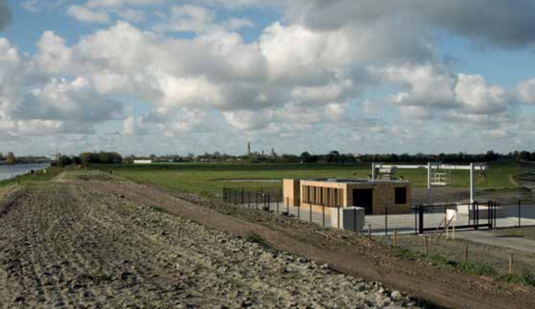
Links: gemaal Poppekinderen bij het Kanaal door Walcheren.
